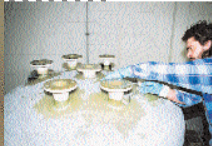
Montage verschiedener Flanschanschlüsse
