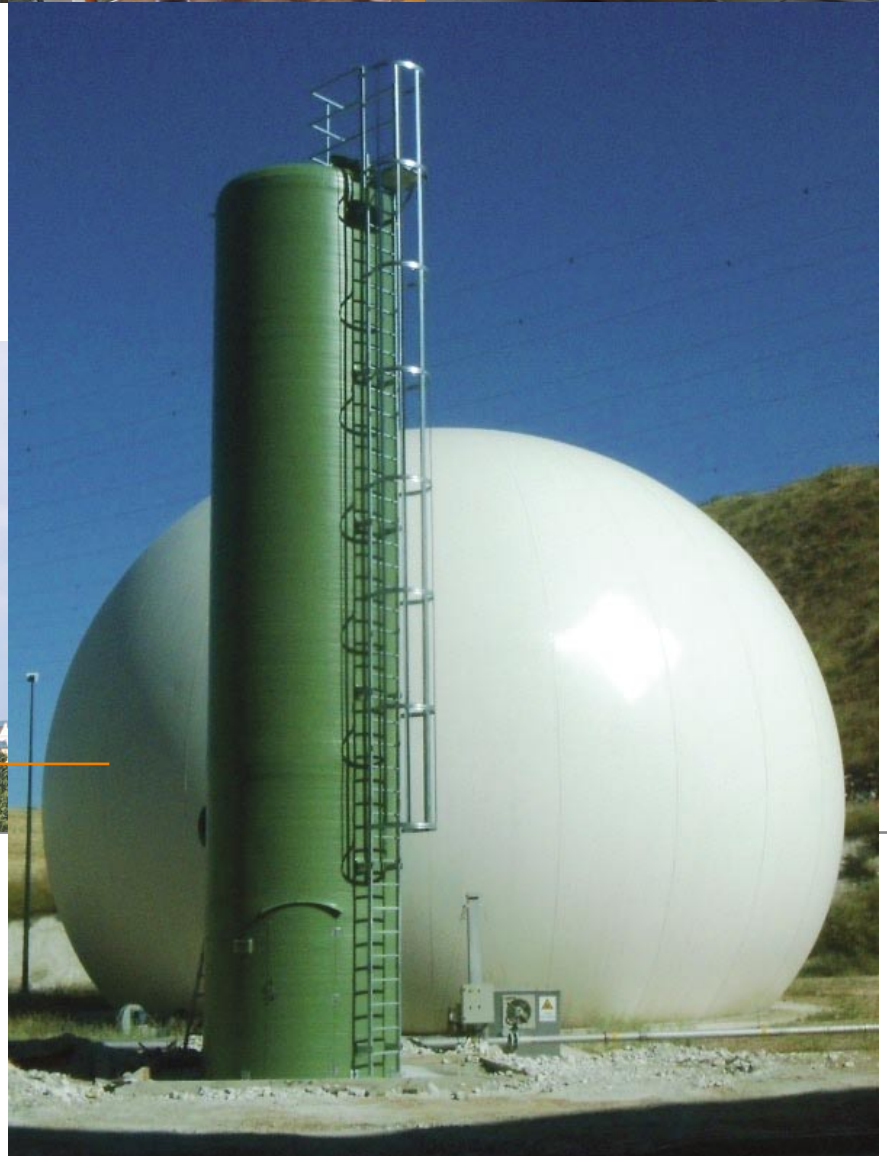
Prozess-Chemikalien umweltgerecht in den Griff bekommen, wie z. B. in der Nickelhütte Aue. Der Reich-Wäscher reinigt die bei der Verbrennung von Ne-metallhaltigen Schlämmen entstehenden Rauchgase aus der chemischen Industrie unter Zusatz einer Kalkstein-Suspension. Die Anlage trägt entscheidend dazu bei, dass die Chemie nicht zum Risiko für die Umwelt wird.
