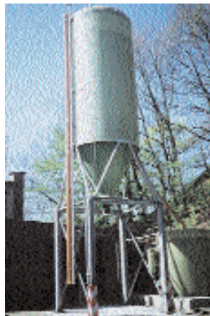
Streusalzsilos mit beigeinstalliertem Soleerzeuger für den kommunalen Winterdienst
