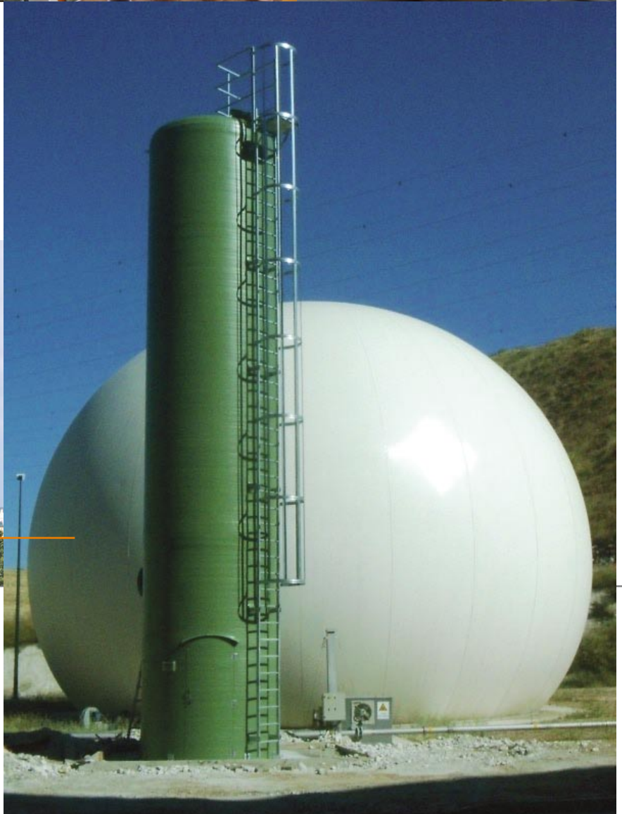
Prozess-Chemikalien umweltgerecht in den Griff bekommen, wie z. B in der Nickelhütte Aue. Der Reich-Wäscher reinholt die bei der Verbrennung von Ne-metallhaltigen Schlämmen entstehenden Rauchgase aus der chemischen Industrie unter Zusatz einer Kalkstein-Suspension. Die Anlage trägt entscheidend dazu bei, dass die Chemie nicht zum Risiko für die Umwelt wird.
